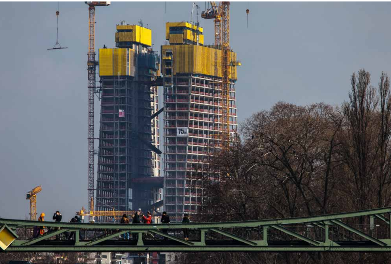
In 2012 begon het nieuwe hoofdkwartier van de ECB vorm te krijgen als een nieuw opvallend element in de skyline van de stad Frankfurt. De hoogbouw vorderde iets sneller dan verwacht, met ongeveer één verdieping per zes dagen.
