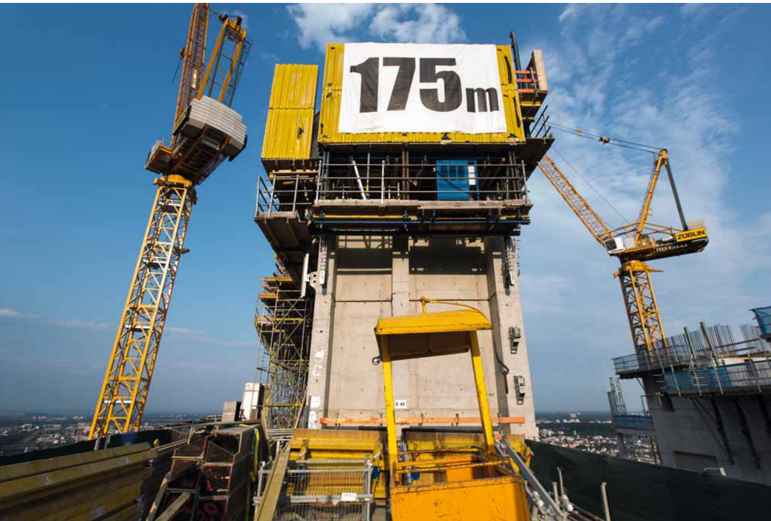
De dubbele kantoortoren bereikte in juli 2012 een hoogte van 175 meter. Aan de oostzijde van de hoogbouw wordt thans gewerkt aan het skelet voor de beglazing van het atrium.
